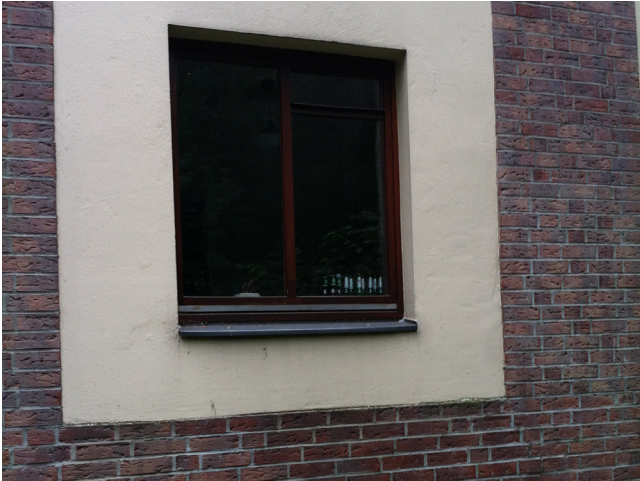
Putzbereiche in der Fassade
