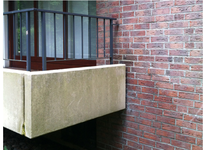
Ansicht auskragende Balkone und deren Brüstung
